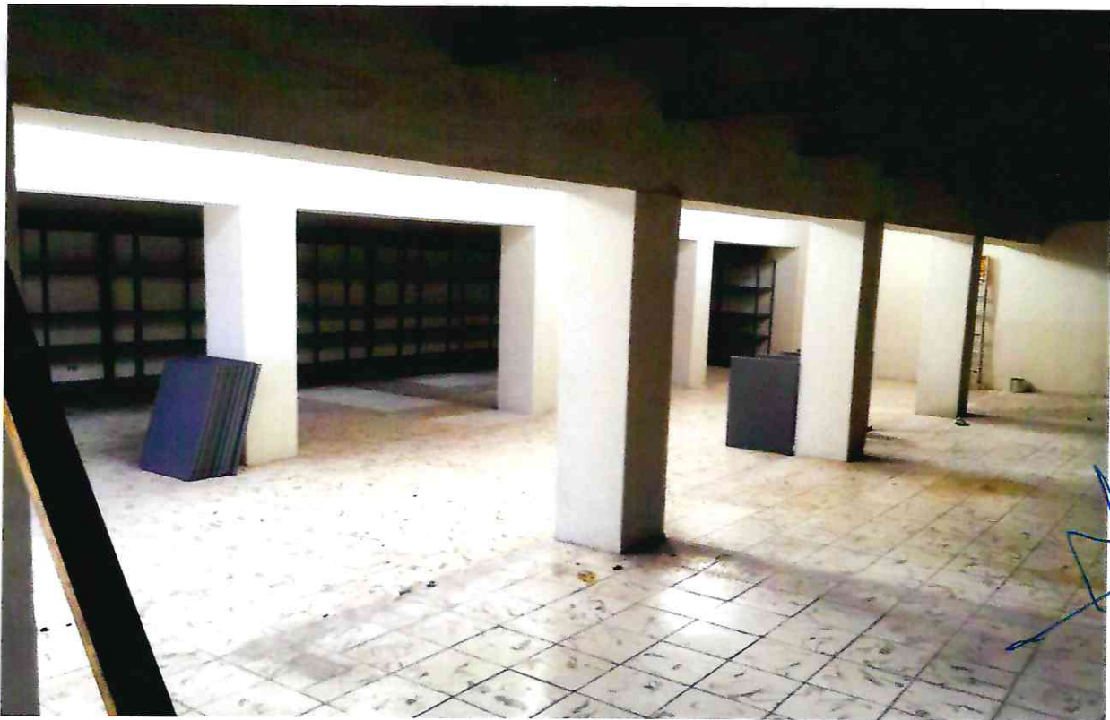
Anclaje de estanterías a muro
