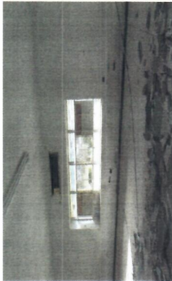
13 SUMINISTRO E INSTALACION DE VENTANERIA DE HERREIA DE 0.40 X .74 CON VIDRIO DE 3MM Y TELA MOSQUITERA
