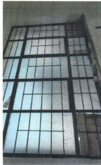
14 SUMINISTRO E INSTALACION DE VENTANERIA DE HERREIA DE 1.75 X 1.07 CON VIDRIO DE 3MM Y TELA MOSQUITERA
