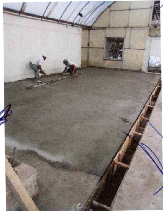
SE REALIZAN LOS ACABADOS DE APLANADO Y FLOTEADO DEL PISO DEL PRIMER TUNEL
