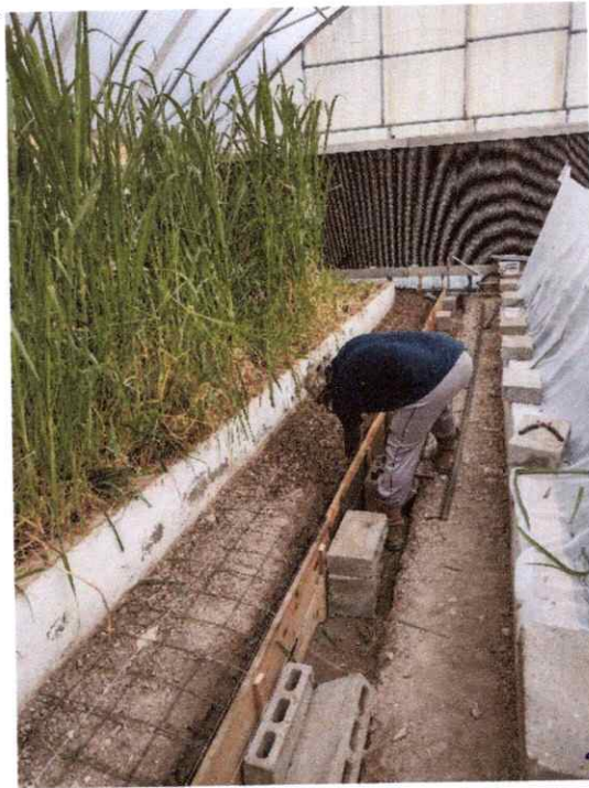
COLOCACION DE ANGULO PARA BASTIDOR DE REJILLA
