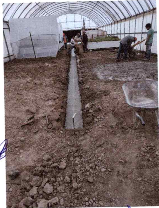
DE IGUALMANERA, SE REALIZO EL TENDIDO DE CONCRETO EN LA PLANTILLA DEL CANAL DE DESAGUE
