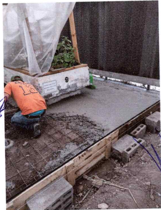
SE PROCEDE AL TENDIDO DE CONCRETO, EN ESTE PROCESO FUE DONDE SE EMPOZO A DIFICULTAR EL TRABAJO, POR LAS CAMAS YA EXISTENTES
