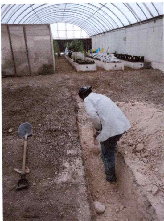
EXCAVACION DE ZANJA PARA DRENAJE
