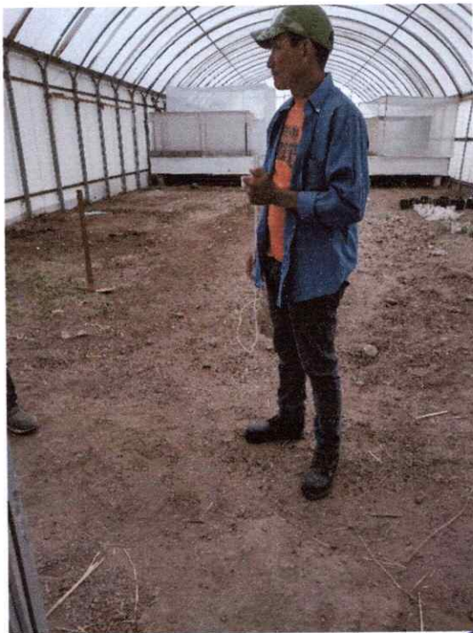
CORRIDO DE NIVEL DE TERRENO Y MARCACIONES
