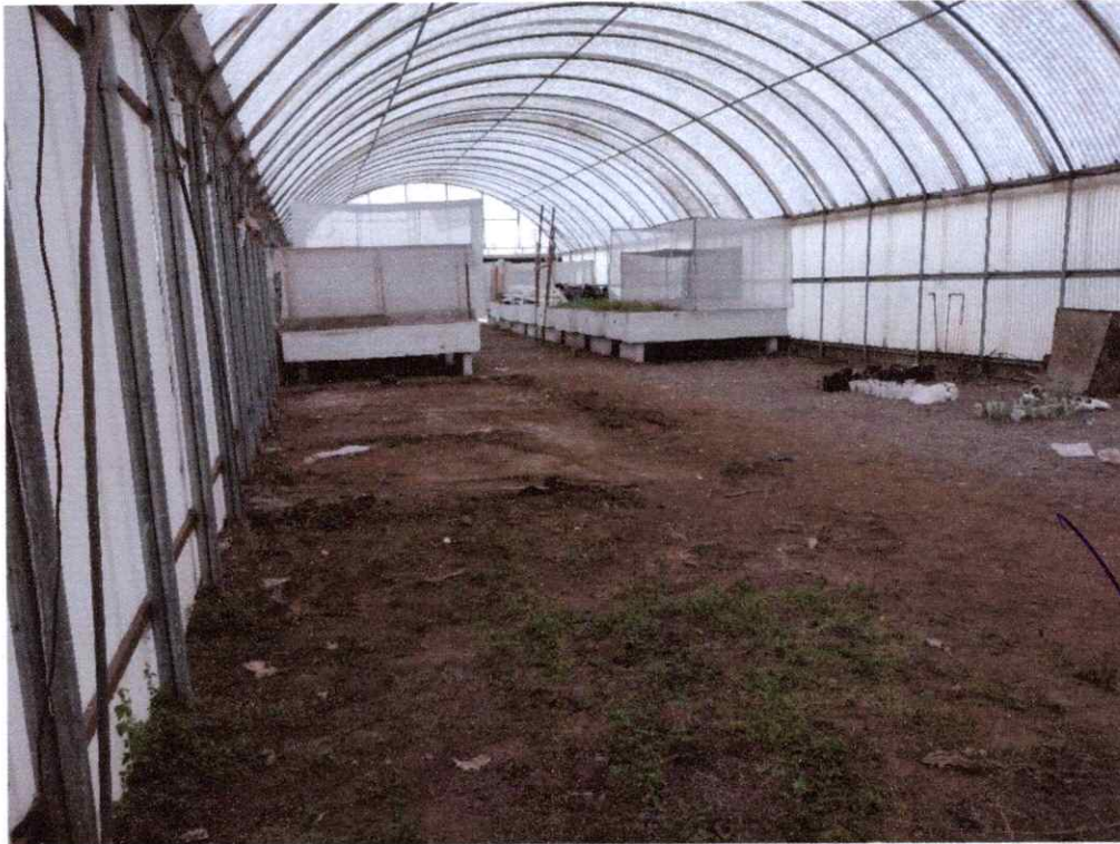
VISTA GENERAL DEL INTERIOR DE LOS TUNELES DEL INVERNADERO No. 9 DE PARASITOLOGIA
