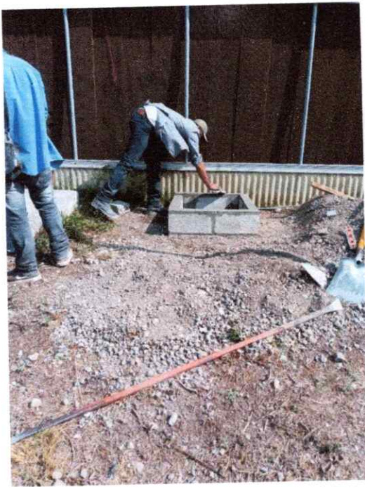
CONSTRUCCION DE REGISTRO DEL CANAL DE DESGUE
