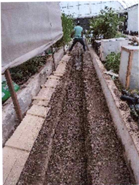
TENDIDO DE PISO EN CANAL DE DRENAJE
