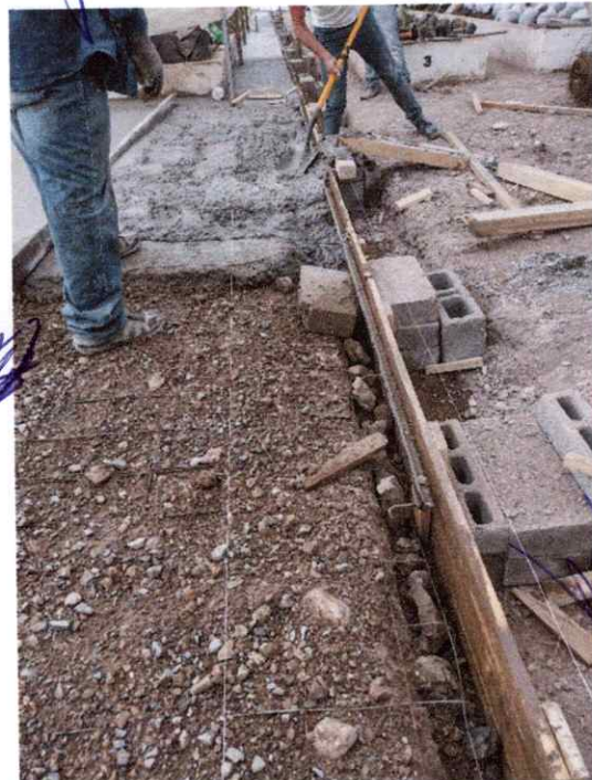
AVANCES DEL TENDO DE CONCRETO
