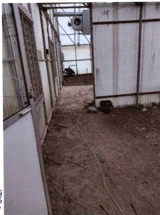
NIVELACION DE PISO DE TUNELES
