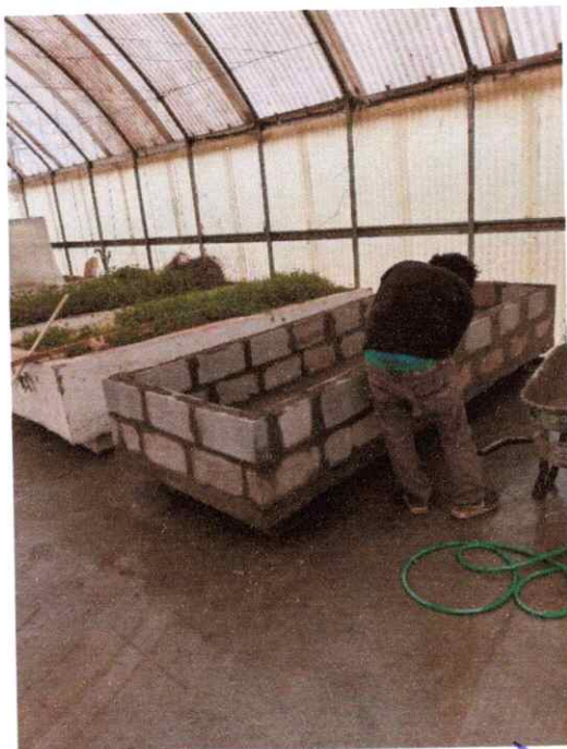
CONSTRUCCION DE MUERETES DE CAMAS
