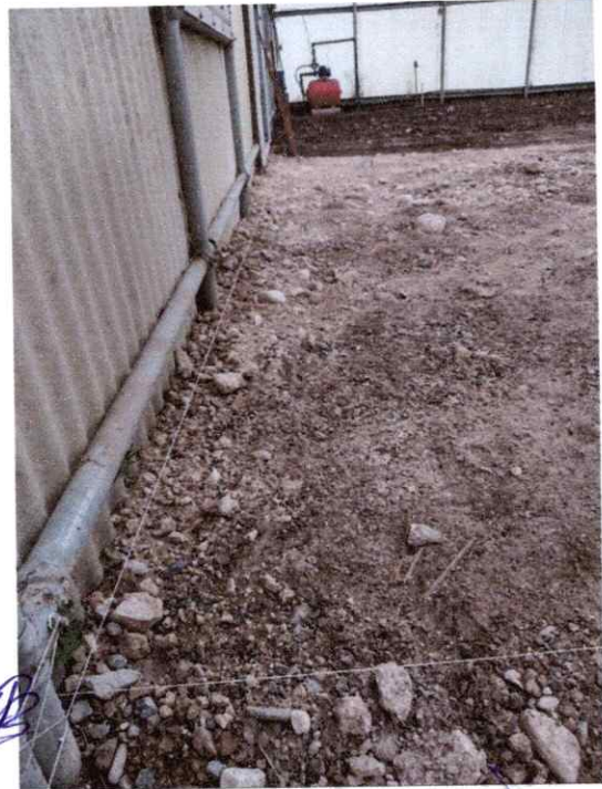
EL TENDIDO DEL RELLENO SE USO AGUA Y PIZON PARA LA NIVELACION Y DESNIVEL DE ESCURRIMETO
