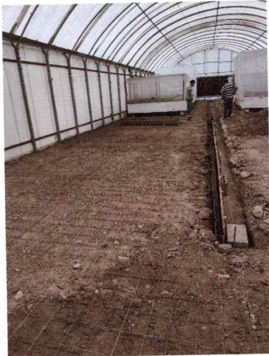
Y POSTRIORMENTE, SE REALIZÓ EL TENDIDO DE LA MALLA ELECTROSOLDADA Y ENCOFRADO DEL MISMO
