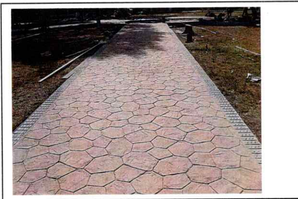
UNCIADO DE PISO DE CONCRETO ESTAMPADO
