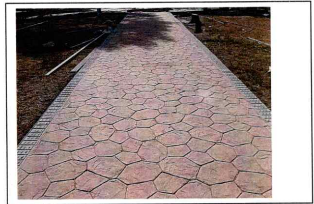
UNCIADO DE PISO DE CONCRETO ESTAMPADO
