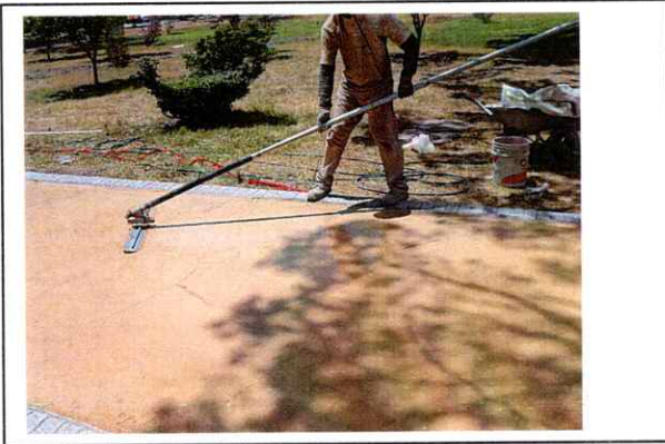
UNCIADO DE PISO DE CONCRETO ESTAMPADO
