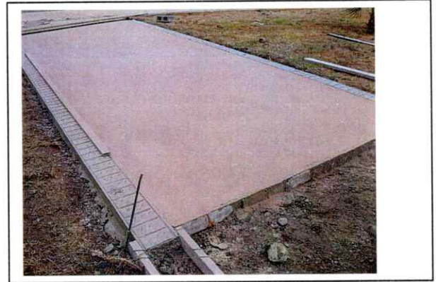
UNCIADO DE PISO DE CONCRETO ESTAMPADO
