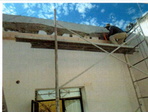
Reparación pretil con block de concreto.
