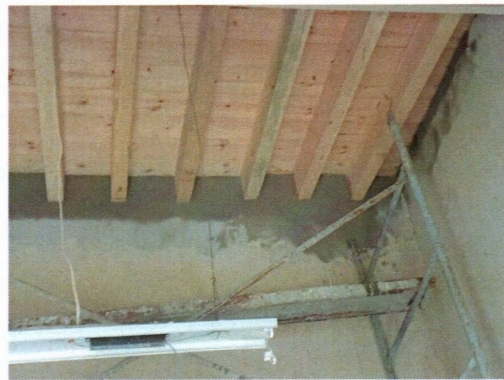
Detalles de pasta para sellar vigas en muro.
