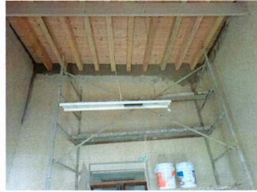
Detalles de pasta para sellar vigas en muro.
