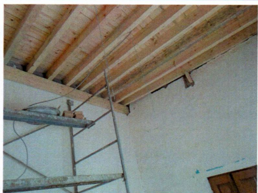
Colocación de vigas y tableta de madera nueva.
