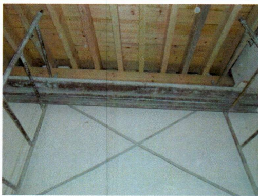
Colocación de vigas y tableta de madera nueva.
