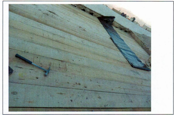
Colocación de plástico sobre tableta de madera.
