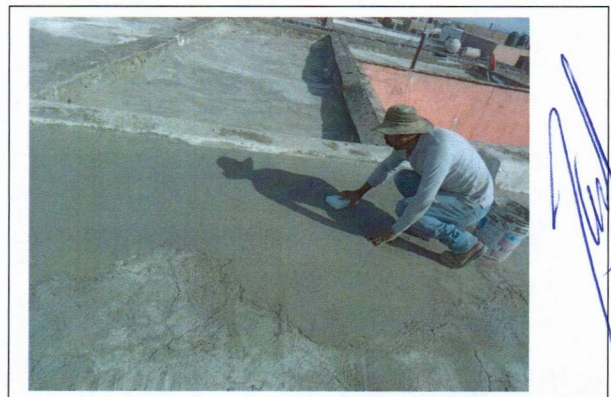
Colocación y compactación de tierra ceniza.
