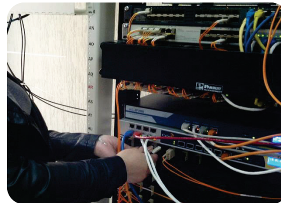
Trabajos en "site". Sede Saltillo
