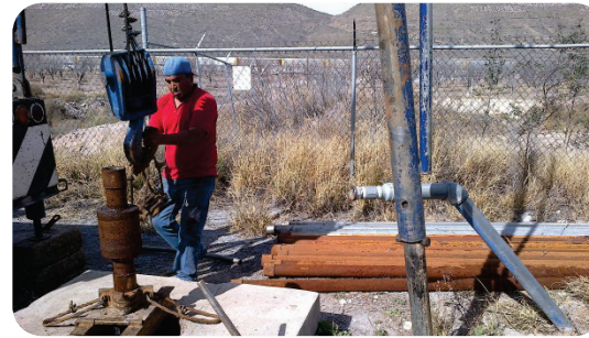
Trabajos en pozos de agua
