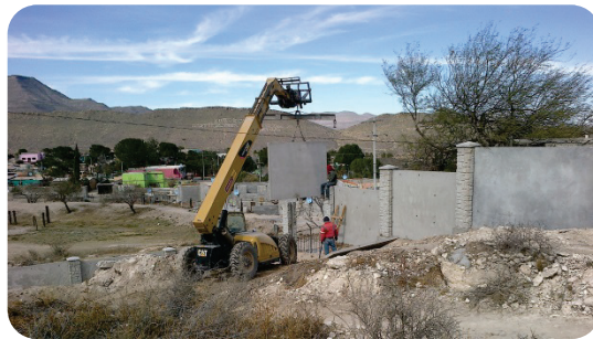
Barda Perimetral 2da. etapa
